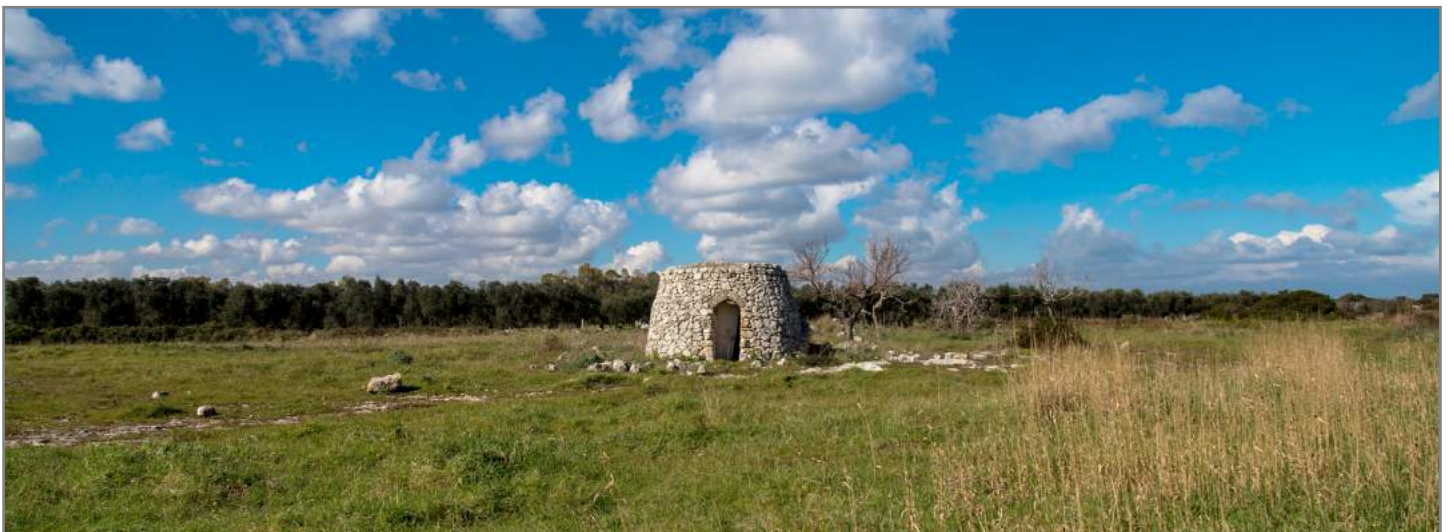
La «pagghiara», struttura rurale tipica salentina, costruita con i massi recuperati dal dissodamento del terreno, da parte dei contadini The “pagghiara” (conical-shaped dry stone shelter often made by th farmer himself using the stones on his land)
