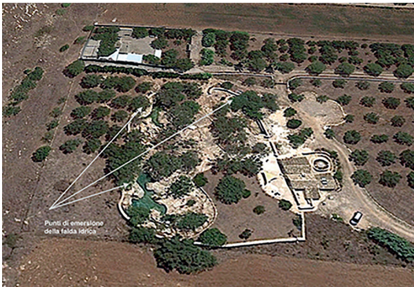
Fig. 15. Vista area della Spunnulata della Pajara con i punti di emersione delle acque di base.
