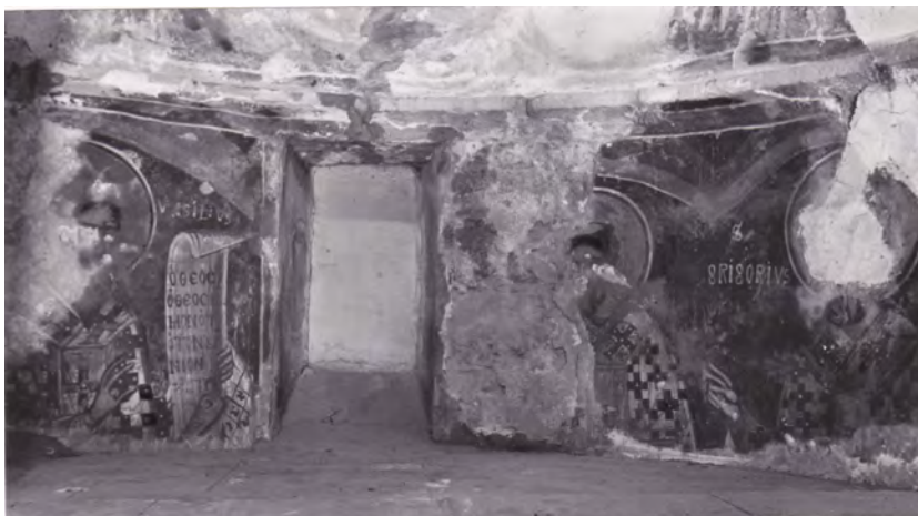
Fog. 14 - Laçi – La Chiesa di San Giorgio – Il retroaltare [1940] (© Franco Tagliarini)
