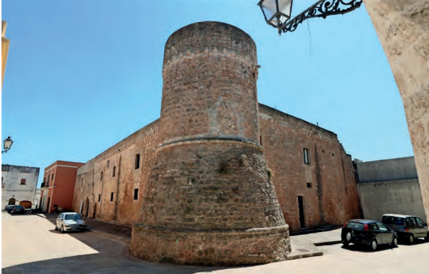
Fig. 2 - Il «torrioncello terrapienato» superstite del castello.
