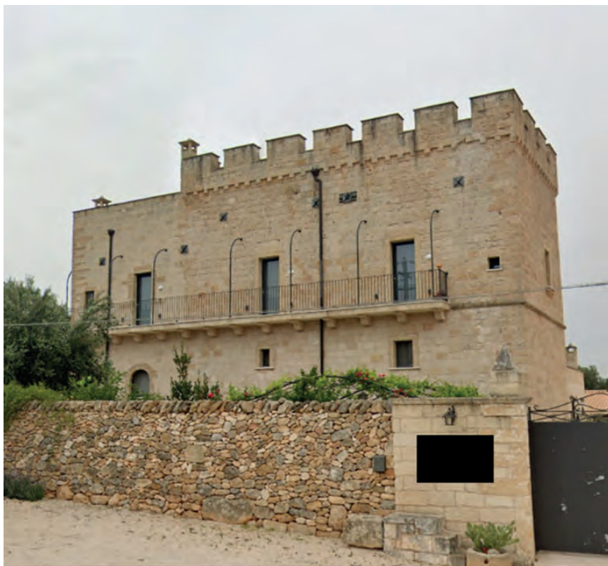
Fig. 6 - La torre merlata adibita a caserma fatta erigere dal principe di Taranto Giovanni Antonio Orsini del Balzo, oggi situata in contrada Antoglia nel comune di Villa Castelli.
