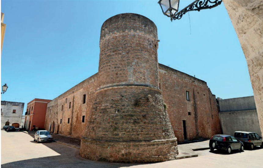
Fig. 2 - Il «torrioncello terrapienato» superstite del castello.
