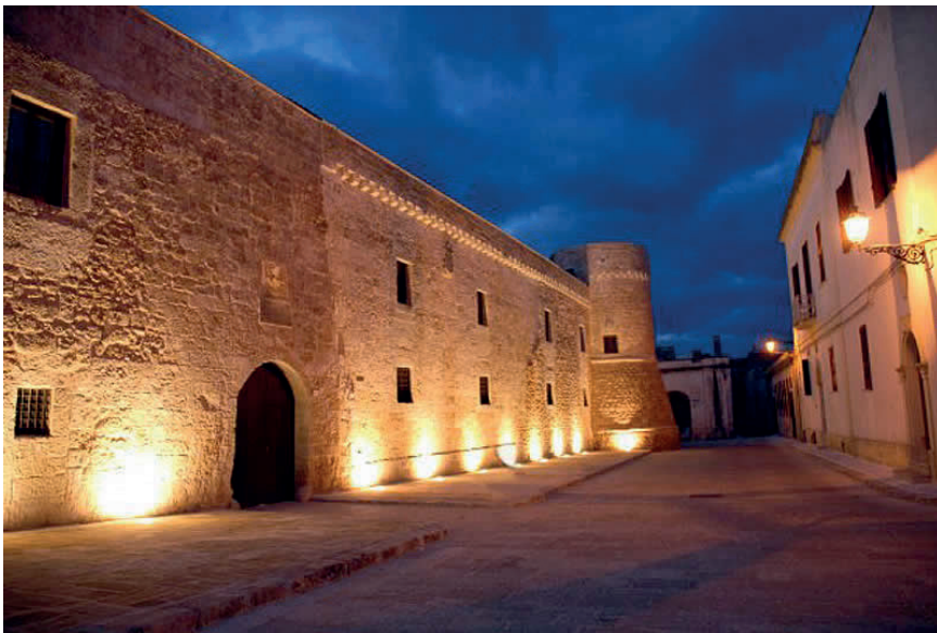
Fig. 1 - Prospetto frontale del castello di Acquarica del Capo. Notare la giunzione trasversale tra l'antica muraria normanna (a sx) e quella orsiniana (a dx), tipico dei rimaneggiamenti di quell'epoca.
