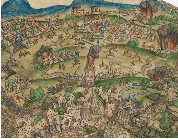
Abb. 12: Der nach König Ladislaus Postunus benannte Laßlaturm in der südlichen Wiener Vorstadt Wieden, 1529/30; hier die Nordfassade, während auf der „Flucht nach Ägypten“ (Abb. 11) die Südseite zu sehen wäre. – Gedrehter Ausschnitt aus der Rundansicht Wiens des Niclas Meldeman, 1529/30; Wien Museum, Inv. Nr. 48.068.
