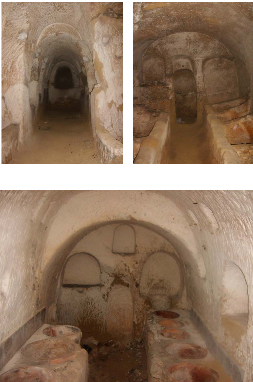
Figg. 7-8-9. Gli spazi scavati nell'arenaria e adibiti alla conservazione e alla lavorazione delle olive all'interno del trappeto "Di Maina". Archivio fotografico Marco Ciano.
