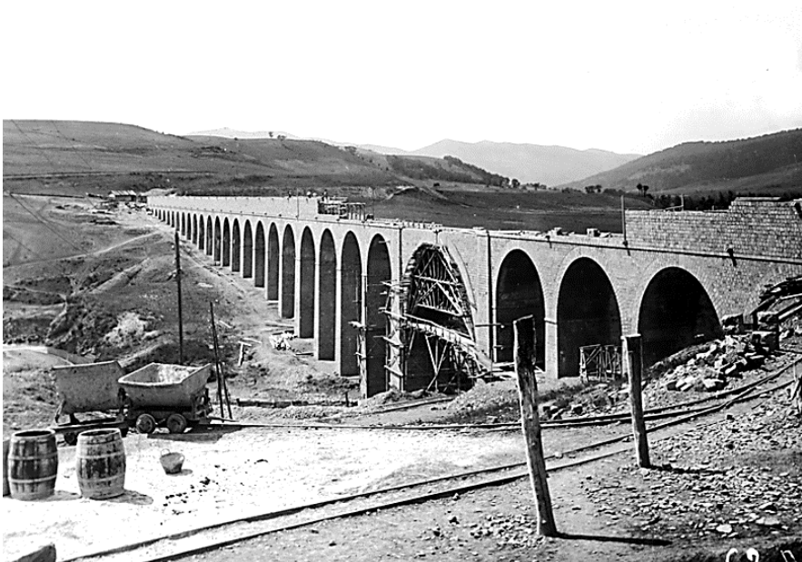
Fig. 3 - Il Ponte-canale e viadotto sulla fiumara di Atella.
