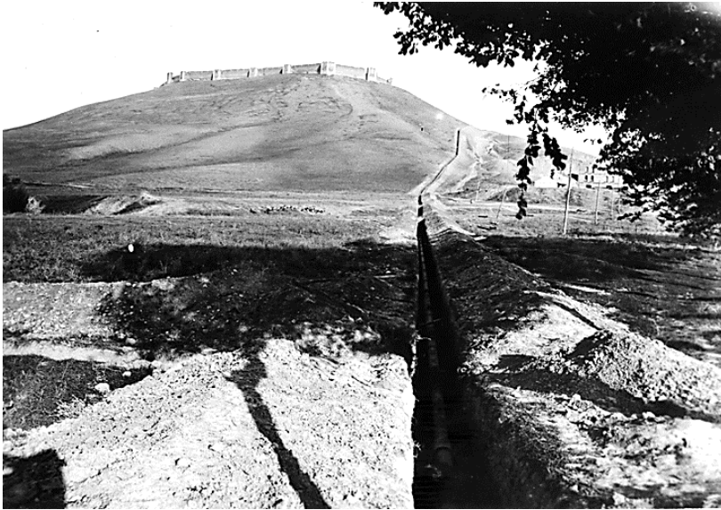
Fig. 5 -Un esempio di un lungo scavo per una condotta in pressione con il castello di Lucera sullo sfondo.
