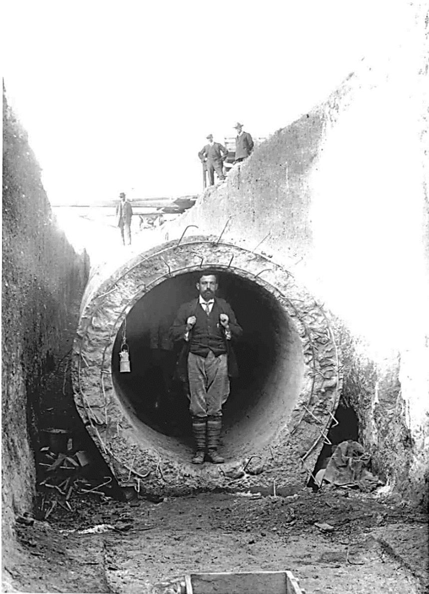
Fig. 4 - Sezione del tubo in cemento armato del sifone sulla fiumara di Venosa
