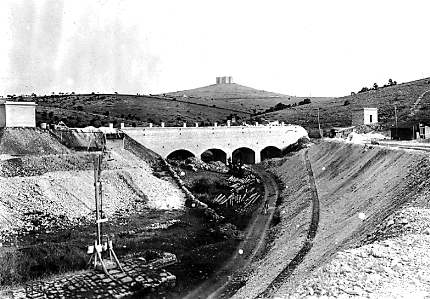
Fig. 2 - Il ponte-canale-viadotto Macenzano, in prossimità di Andria con Castel del Monte sullo sfondo
