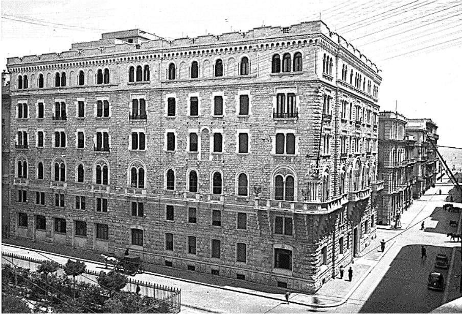
Fig. 7 - Palazzo storico dell'Acquedotto Pugliese a Bari.
